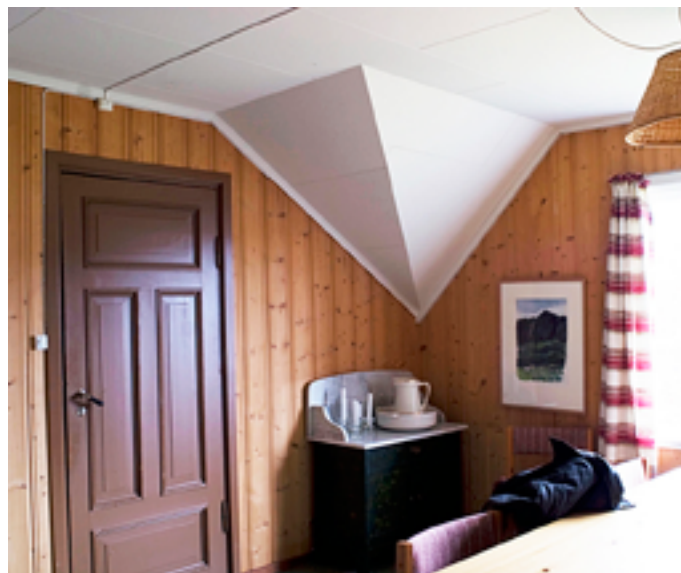
De to rommene i annen etasje ble modernisert på 1980-tallet for å huse prisvinnere. Bak plater og panel skjulte det seg imidlertid opprinnelige interiører.
