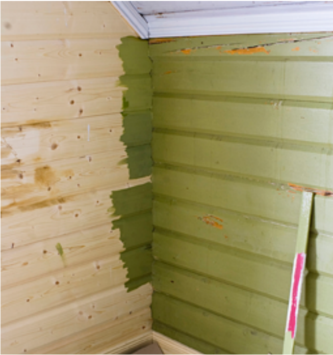
Gavlveggene ble utført som "falske" laftevegger og tilpasset de opprinnelige veggene ved at de ble malt opp likt. Prøver.
